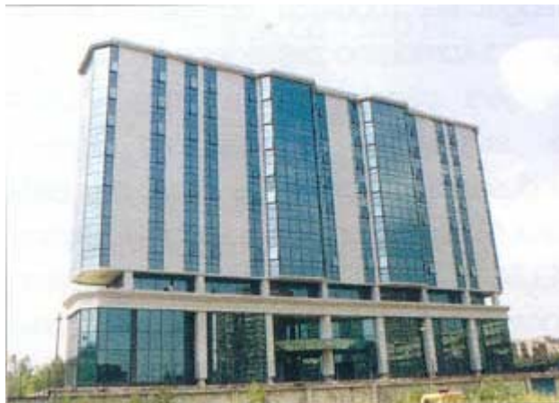
Slika 1 - Fasada zgrade DELTA HOLDINGA u Beogradu
